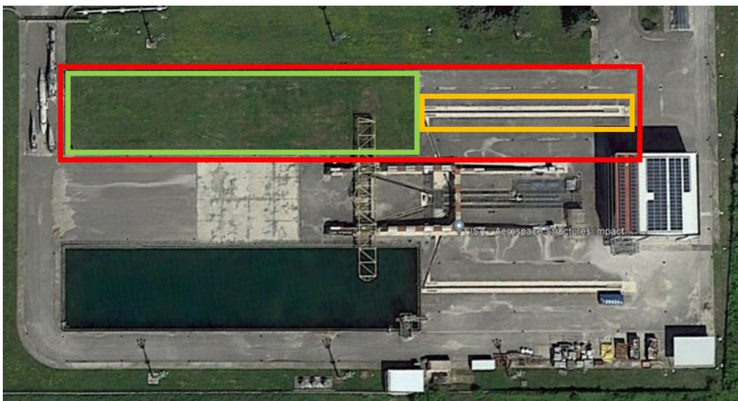
Figure 3: Vista dall'alto delle aree di esecuzione dei test LST (riquadro rosso); dell'area di installazione della facility LST (riquadro giallo) e dell'area di atterraggio del mock-up (riquadro verde)
